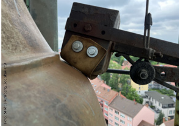
Lederummantelter Schlaghammer der Glocke im Laufer Schlagturm.
