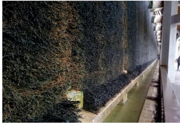
Im Gradierhaus rieselt hochdosierte Sole über eine 23 Meter hohe Wand aus Schwarzdornbüscheln.
